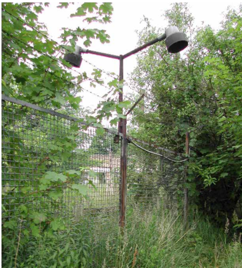
Abb. 38: Leuchte im untersuchten Areal, Foto: 29.06.2003 (Quelle: Fotoarchiv, Lehrstuhl Denkmalpflege BTU Cottbus), nicht mehr vorhanden seit 2016
