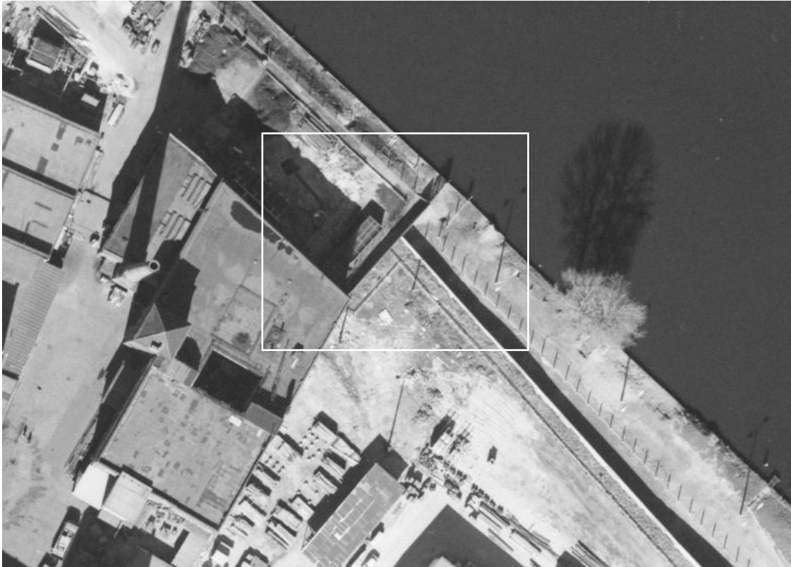
Abb. 45: Grenzsicherung zwischen Grundstück Eisfabrik und Spree durch HSiM und Grenzzaun (Vorfeldsicherung) (Luftbild 1989; Quelle: Geoservice)
