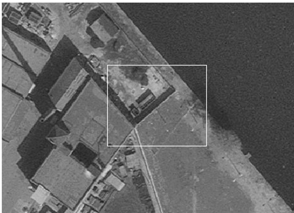
Abb. 44: Grenzsicherung zwischen Eisfabrik und Spree durch Ergänzung der HSiM, quer zur Spree, östliche Begrenzung des Grenzstreifens (Luftbild 1984; Quelle: Geoservice)
