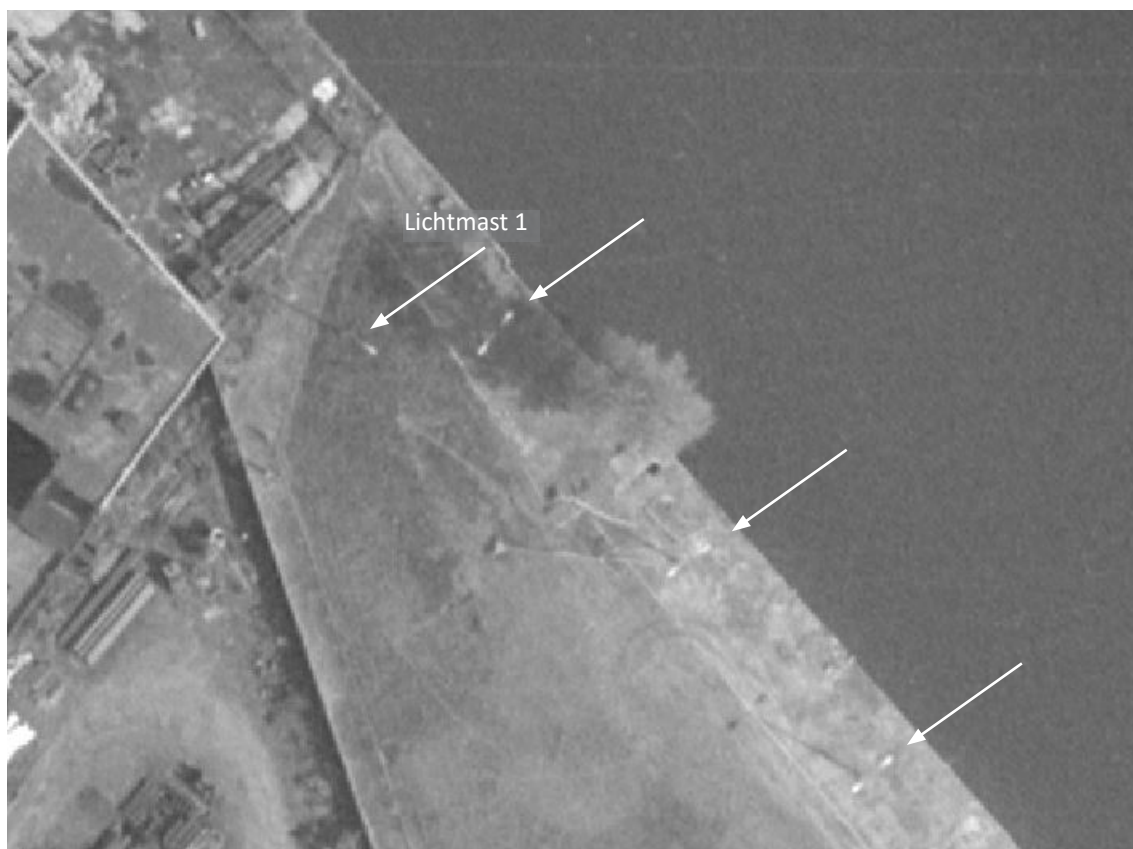
Abb. 47: Lichtmasten vor der Verlegung der HSiM (Luftbild 1979; Quelle: Geoservice)
