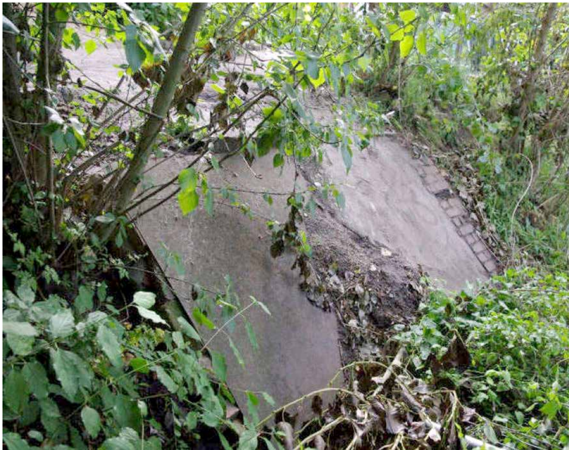
Abb. 46b: Kanalabdeckung mit Stahlplatte (Quelle: Elfert, Erinnerungsräume, S. 15)
