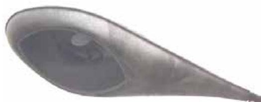
Leider schlecht zu erkennen. Bestückung hier 2x175 W NA Lampe. Die Gehäuse verwittern mit der Zeit, da keine Lackierung aufgebracht wurde.
