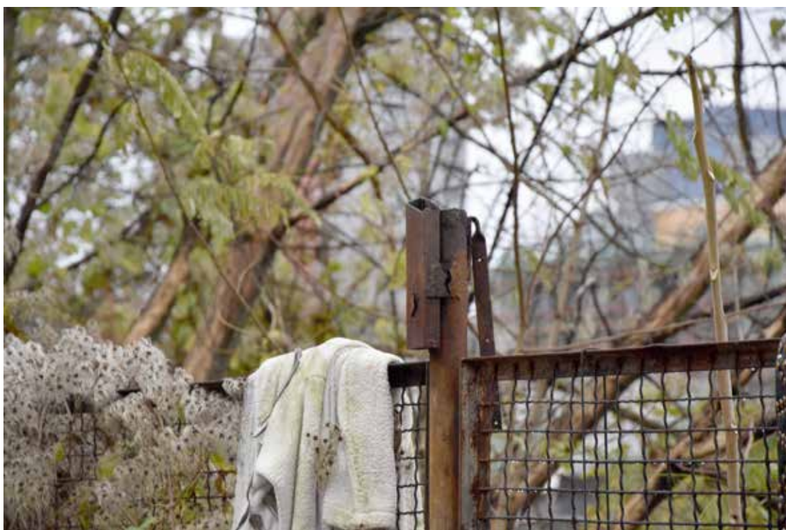
Grenzzaun - Lampenhalterung 3 fehlende Lampe
