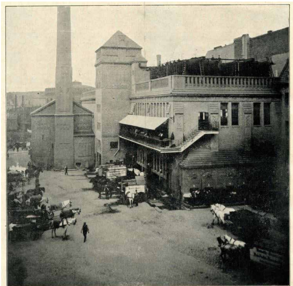
Abb. 20. Fabrikhof der Norddeutschen Eiswerke Akt.-Ges. Berlin; ausgeführt von der Halleschen Maschinenfabrik und Eisengießerei Halle a. S.
