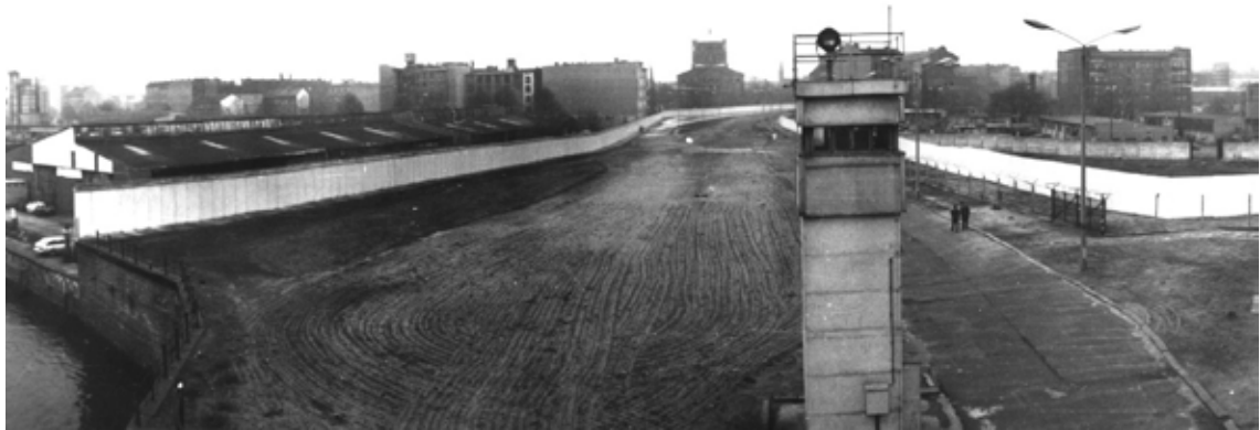
Abb. 9: Blick in den Grenzstreifen entlang des Luisenstädtischen Kanals in Richtung Bethaniendamm, links Vordergrundmauer, mitte: Postenturm, rechts: Hinterlandsicherungsmauer mit Zaunanlage und Tor zum Grenzstreifen, o.D. (1988/89) (Quelle: Berliner Mauer Archiv)
