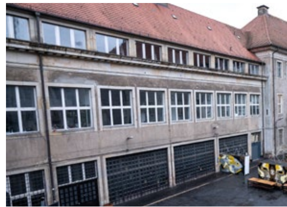
Werkstatt- gebäude Hofseite
