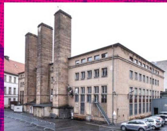
Bauteil VIII: Werkstatt- und Hauptgebäude
