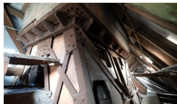
Unter- konstruktion der Schornsteine
